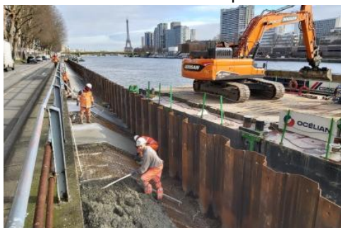
Travaux quai Blériot à Paris - Mise en œuvre du béton sur le perré © HAROPA PORT / DR
