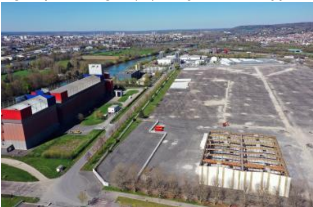
Démontage et désamiantage de bâtiments de l'ancien parking Citroën sur le port de Limay - © HAROPA PORT / JF Damois
